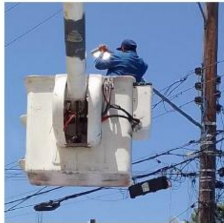
REHABILITACIÓN DE LUMINARIAS HACIENDO CAMBIO DE MATERIAL OBSOLETO; POBLADO CHEMUYIL.
