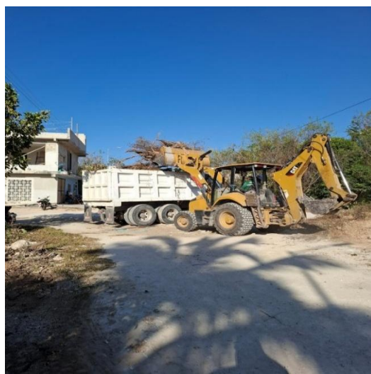
Recolección de ramas. Calle bugambilia entre calle margarita y av. 20 norte; fraccionamiento ya'ax Tulum.
