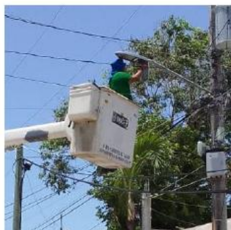
CAMBIO DE LAMPARAS OBSOLETAS POR LED NUEVAS; POBLADO CHEMUYIL.
