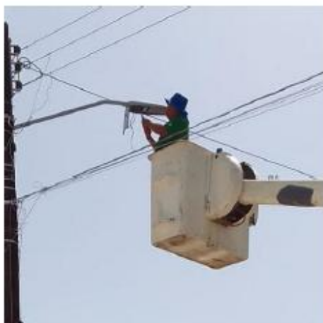
CAMBIO DE LAMPARAS OBSOLETAS POR LED NUEVAS; POBLADO CHEMUYIL.
